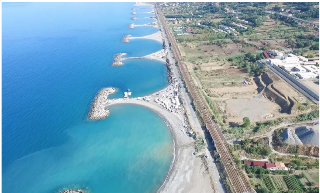
Foto 2: Litorale - particolare vista zona sud confine con San Lucido
